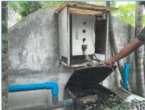
ถังดักไขมันและการจ่ายสารเคมีเพื่อดักจับไขมันเบื้องต้น
