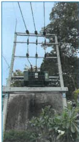
หม้อแปลงไฟฟ้าพร้อมป้ายเตือน
