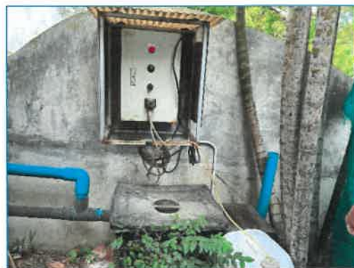
ภาพถ่ายที่ 2.2-8 ถังดักไขมันและการจ่ายสารเคมีเพื่อตกจับไขมันเบื้องต้น
