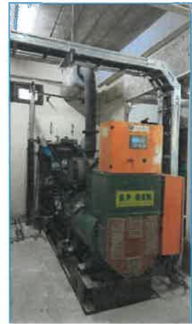
เครื่องกำเนิดไฟฟ้าสำรองของโรงแรม
