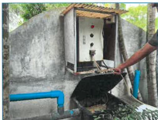
ภาพถ่ายที่ 2.2-8 ถังดักไขมันและการจ่ายสารเคมีเพื่อตกจับไขมันเบื้องต้น
