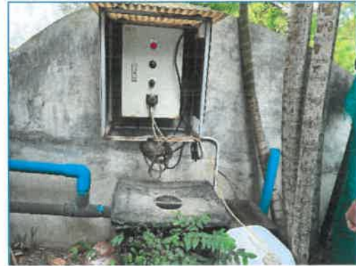
ถังดักไขมันและการจ่ายสารเคมีเพื่อดักจับไขมันเบื้องต้น
